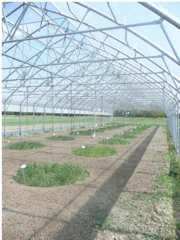
Abbildung 1: Konstruktion des Folientunnels über der Lysimeteranlage, 2. Projektjahr, Anbau Winterweizen, Gelände der AGES GmbH, 1220 Wien. © Helene Berthold
